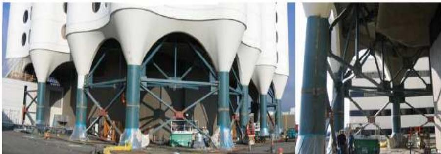
Esempio di applicazione dei Pall friction dampers.
