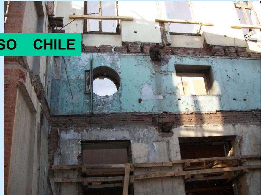
Con posterioridad a la visita, se indicó con urgencia reforzamiento del edificio, se sugiere estructura provisoria de madera, actualmente en construcción.
