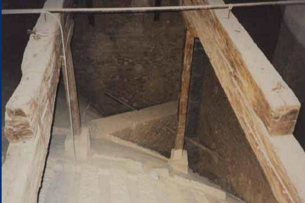
**Preparazione delle zone di applicazione del composito. Scarificazione delle zone con rimozione della cappa originaria. Si notano anche i sostegni delle catene lignee delle capriate che insistono sulle vele delle volte.**
