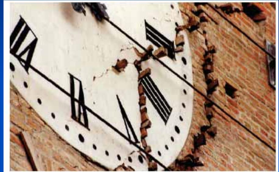
Lavori di indagine e controllo della cinturazione (2000) nel periodo della progettazione. Si nota la profonda lesione nel prospetto Est contenente l'orologio, prospiciente la piazza.
