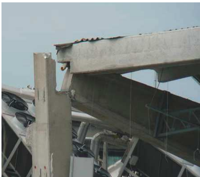
Perdita di appoggio della capriata
