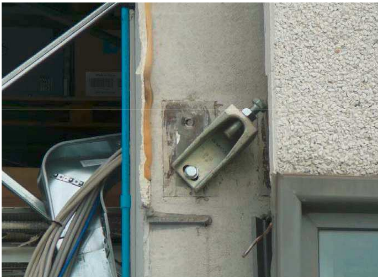
Rottura attacco mensola di supporto pannello e conseguente crollo del pannello
