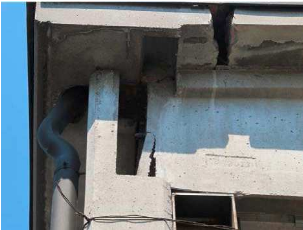
Incipiente perdita di appoggio di una trave principale
