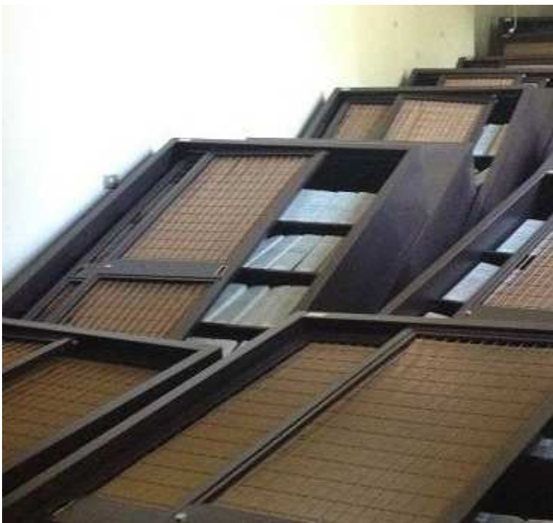
Ribaltamento scaffali e archivi
