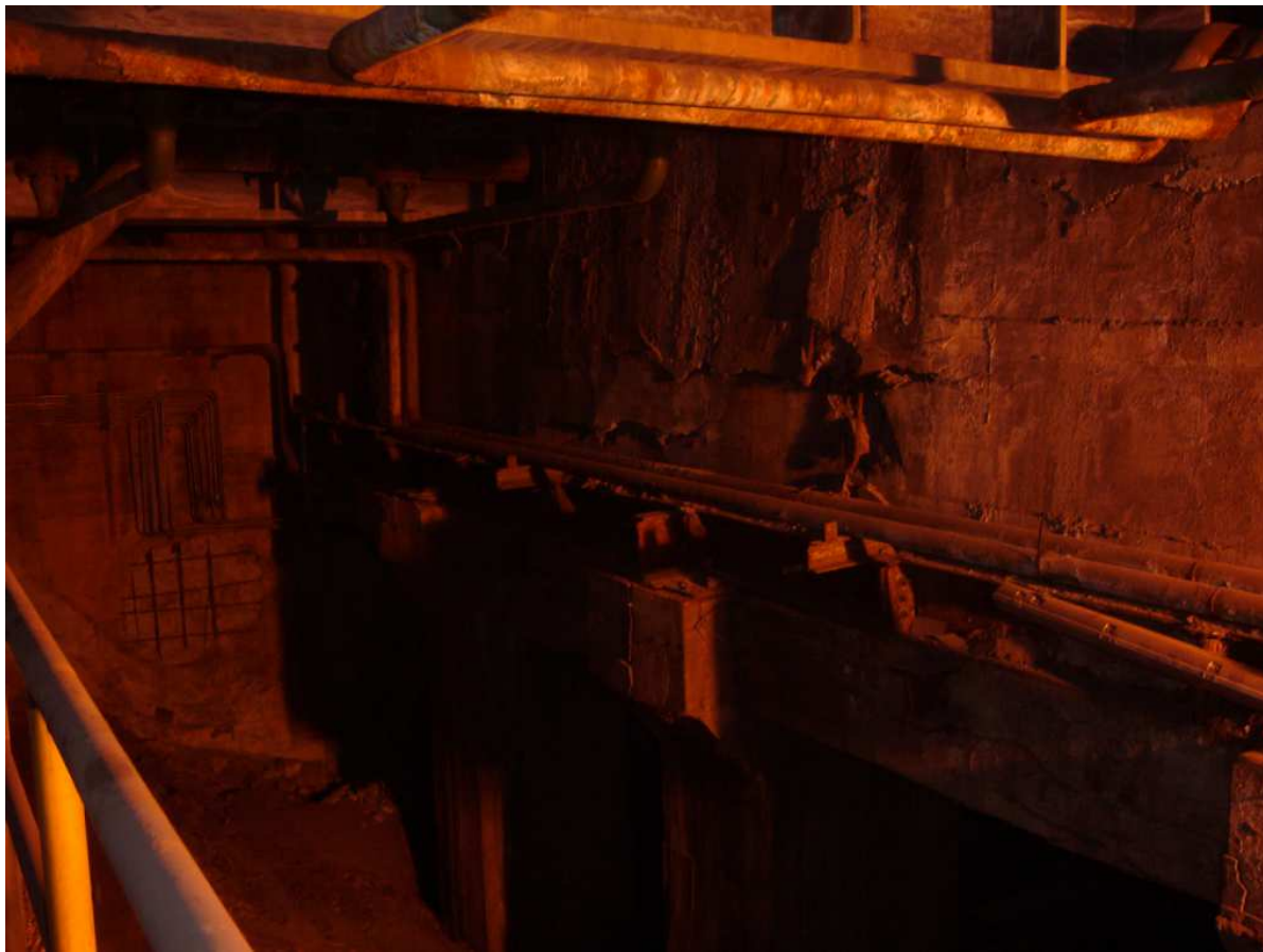
Ammaloramento Travi-Setto / Pilastri
