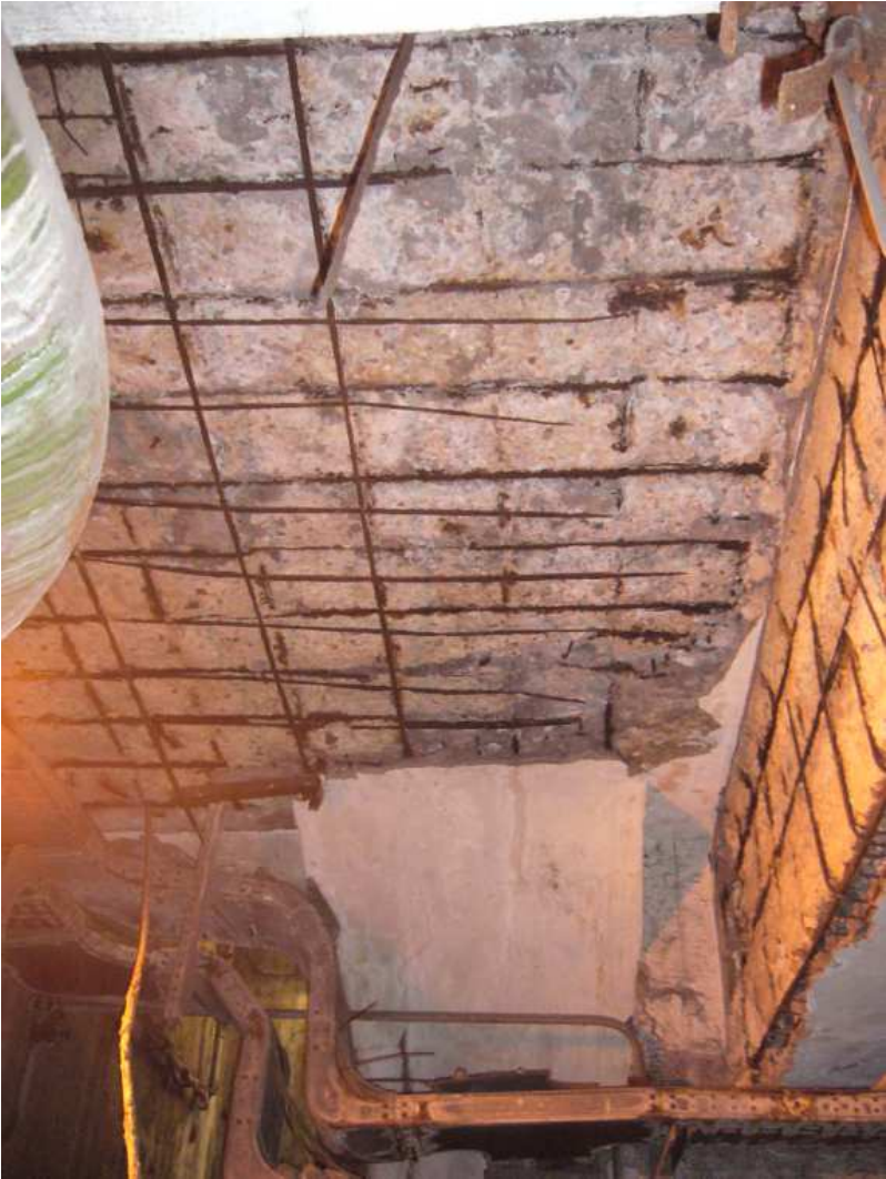
Ammaloramento Solette
