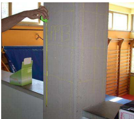
Preparazione elemento da carotare
