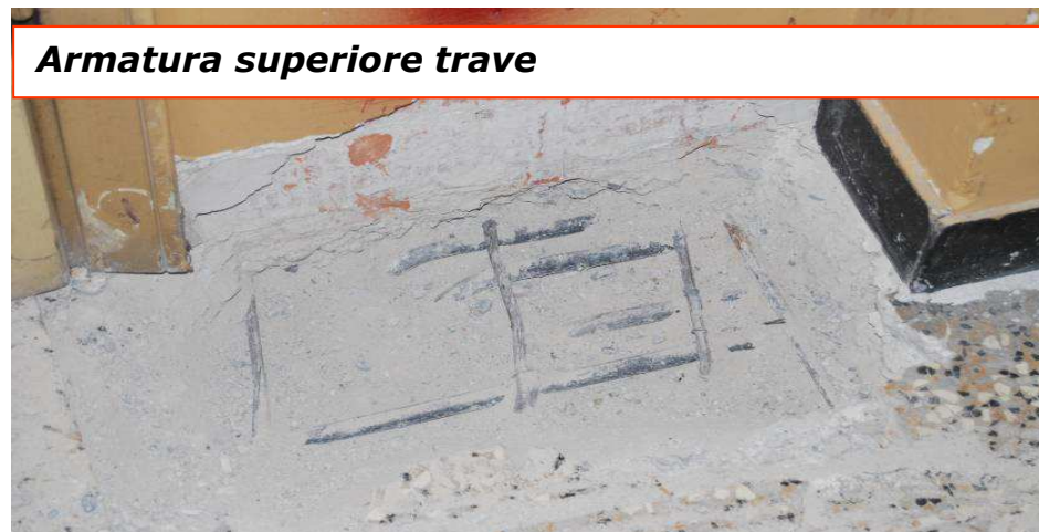
Armatura superiore trave di fondazione
