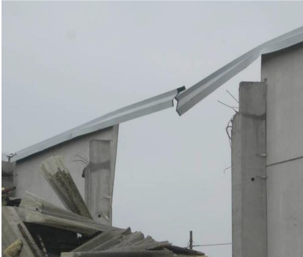
Edificio industriale prefabbricato, Sant'Agostino: sin.) fuoriuscita delle travi, des.) caduta dei pannelli
