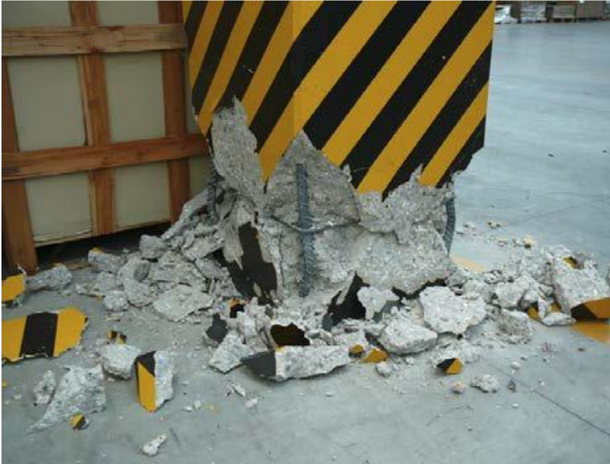
Cerniera plastica alla base di un pilastro
